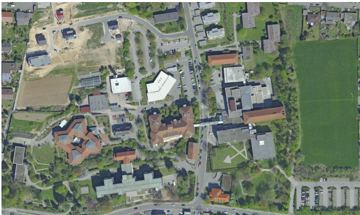
Luftbild des Kreiskrankenhauses Sinsheim
