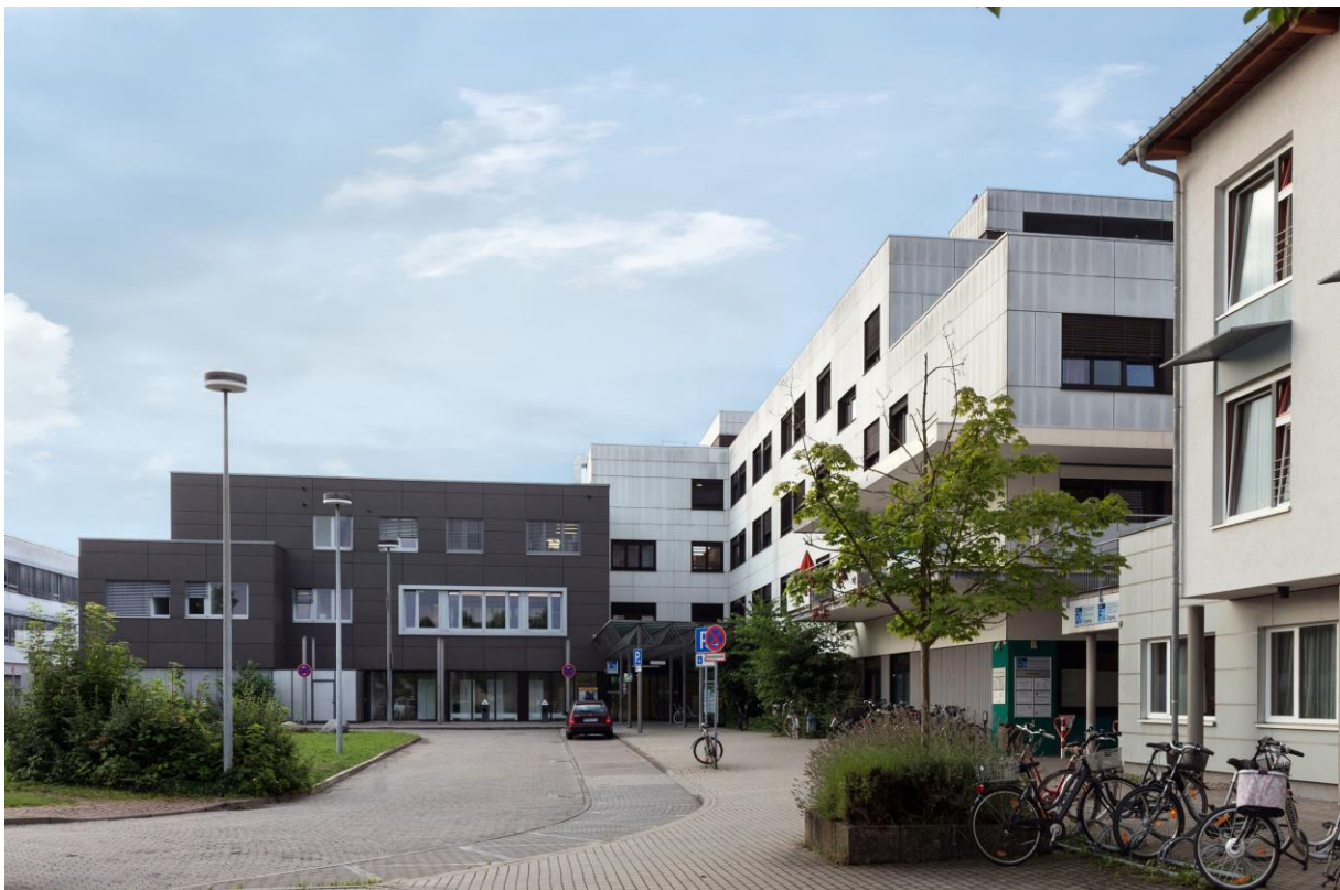
Foto: GRN – Der Eingangsbereich der Klinik in Schwetzingen
