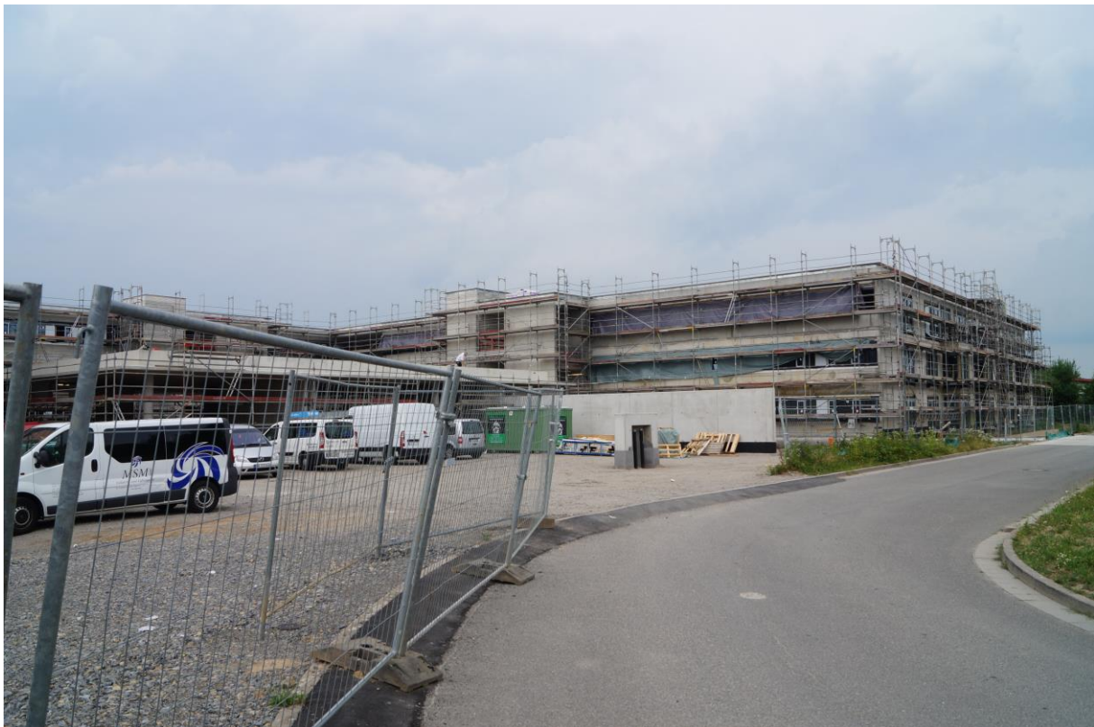
Der Neubau des Betreuungszentrums Weinheim ist in vollem Gange
